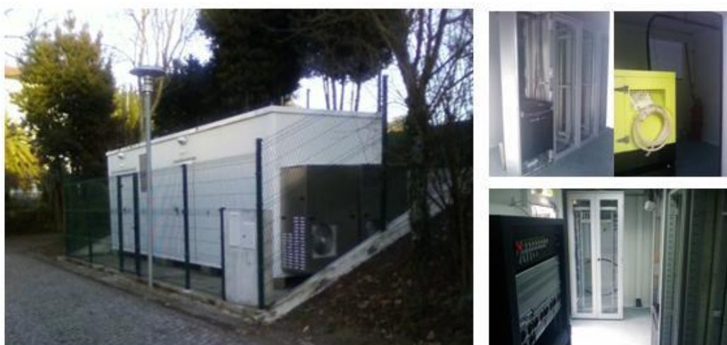
Fig.23 – POP de Ponte de Lima
