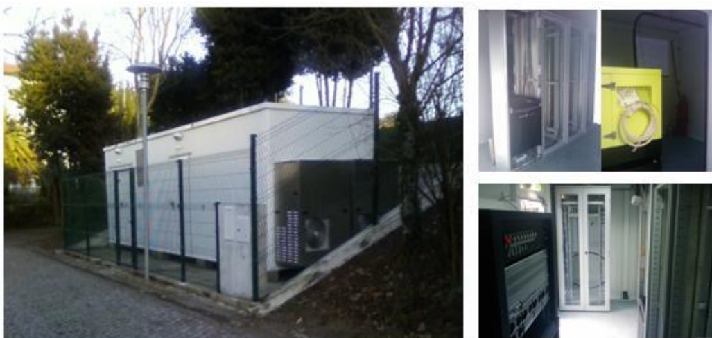
Fig.23 – POP de Ponte de Lima
