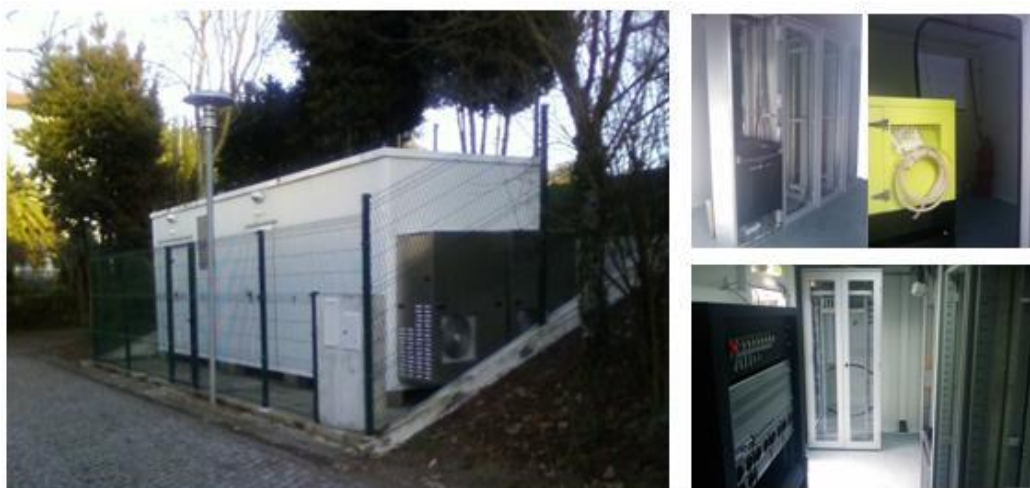
Fig.23 – POP de Ponte de Lima
