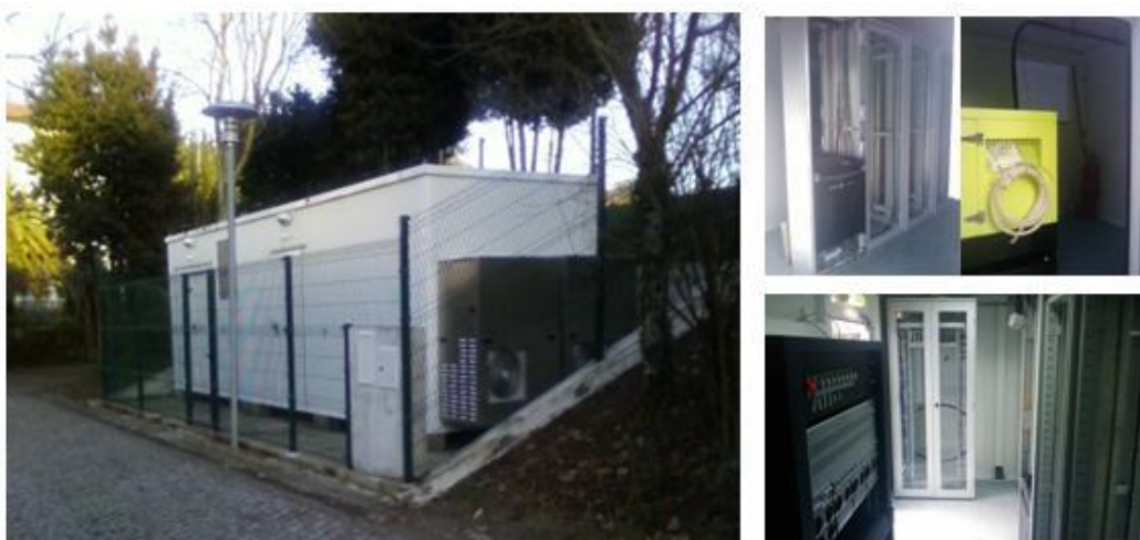
Fig.23 – POP de Ponte de Lima
