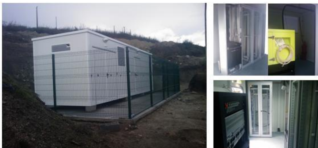
Fig.22 – POP de Ponte da Barca
